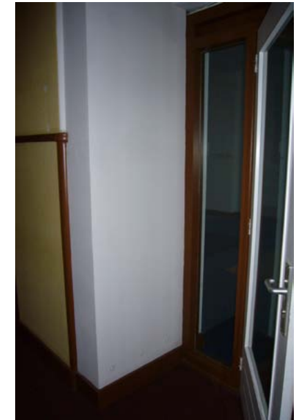
Foto's bestaande situatie
