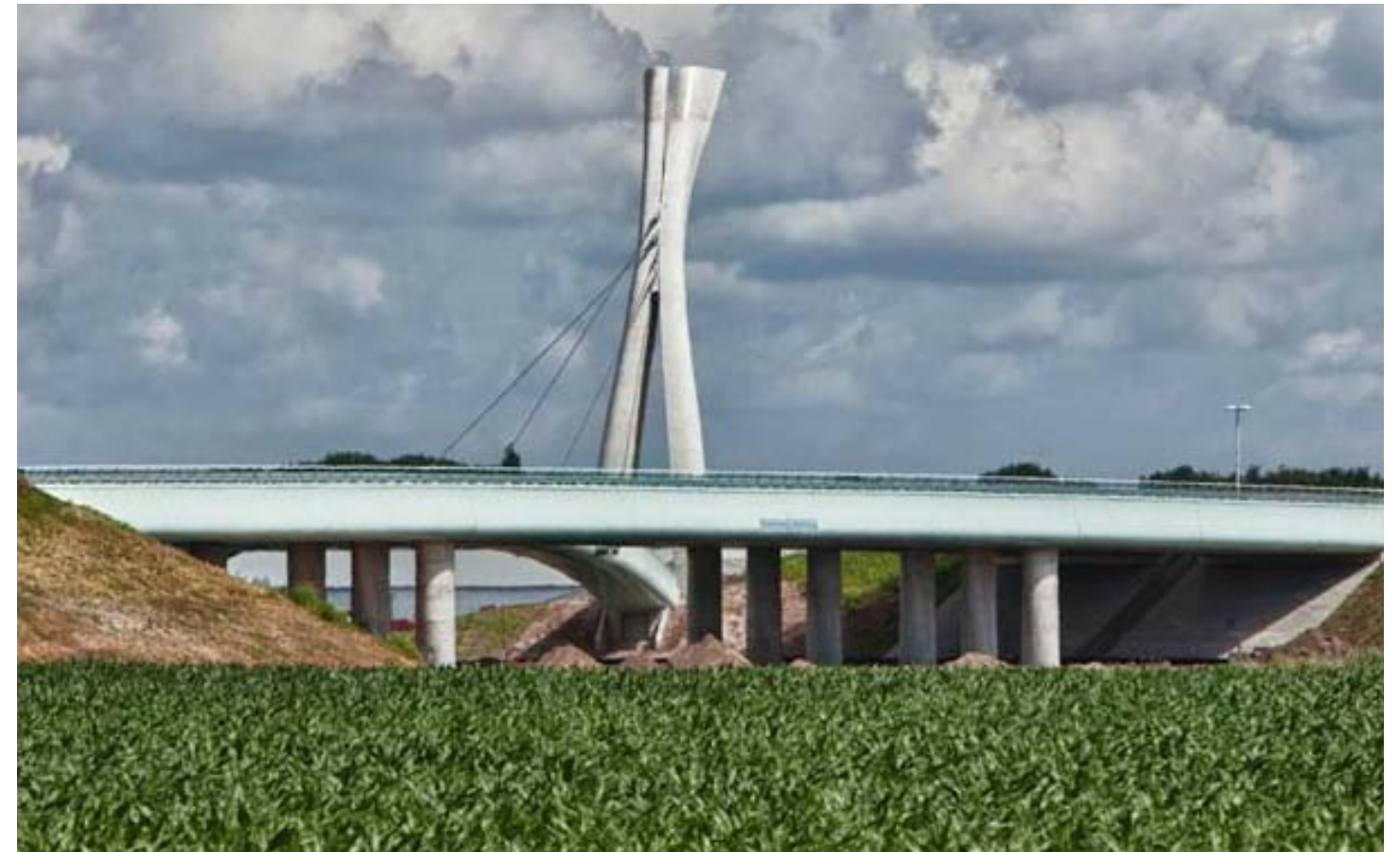
Foto's na de oplevering (door Queeste architecten en Van Hattum en Blankevoort, mrt 2012)
