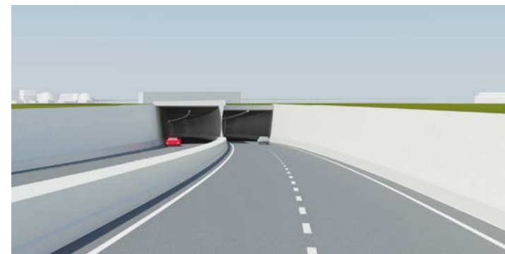
Entree van de tunnel richting de Binckhorst 3. Vlietzone (maaiveld niveau en entree tunnel)
