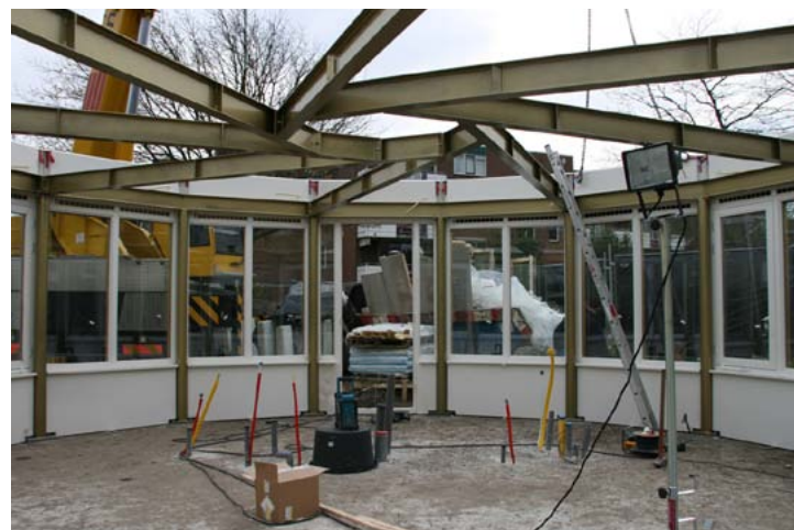
dakconstructie volgens 'Japanse' stapeltechniek
