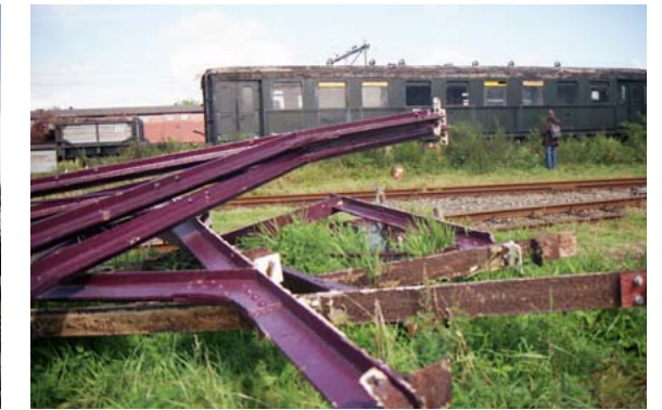
Foto's bestaande situatie
